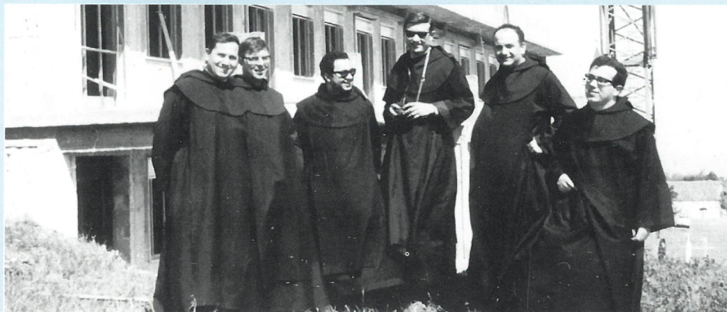
Da sinistra: P. Teresio, P. Pierangelo, P. Vincenzo, P. Gilberto, P. Mario, P. Giusto mentre fervono i lavori del Convento di Trappeto (CT).
